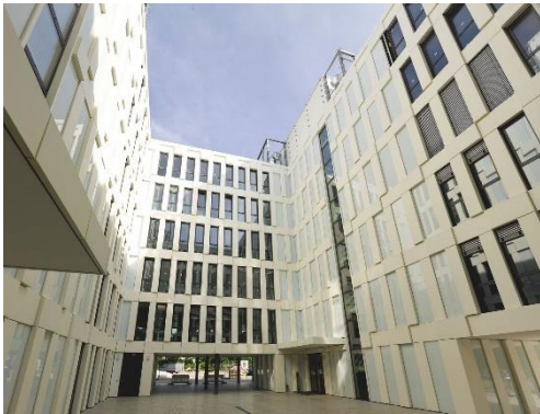
Goldbeck-Bürogebäude, Fasanenhof, Stuttgart
