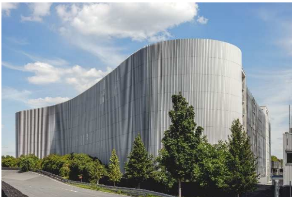
5_GB-Parkhaus.jpg Goldbeck-Parkhaus, Continental Teves AG & Co.oHG, Frankfurt
